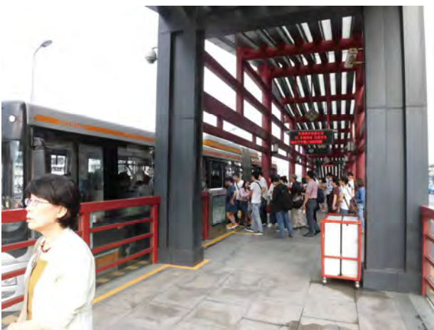
中央分離帯に組込まれた BRT 駅（成都市）
