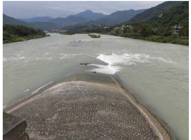
本川と支川の分流施設（都江堰）
