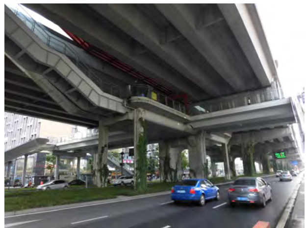
歩道橋と一体整備された BRT 駅（成都市）
