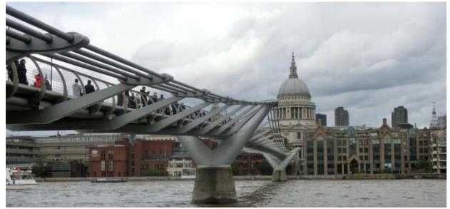
写真-27 ミレニアム・ブリッジの吊橋構造
