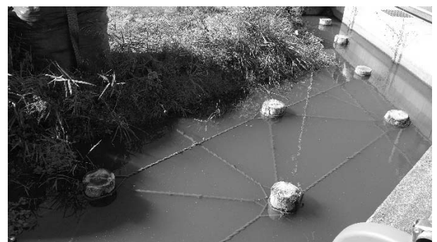
写真2 丸太杭打設状況
